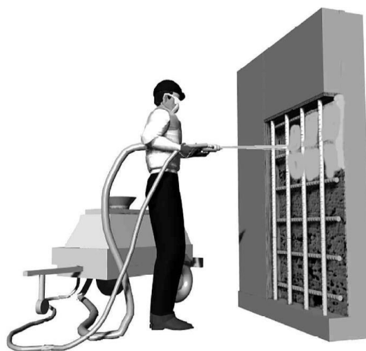
Figura 10 - Aplicação por projeção
