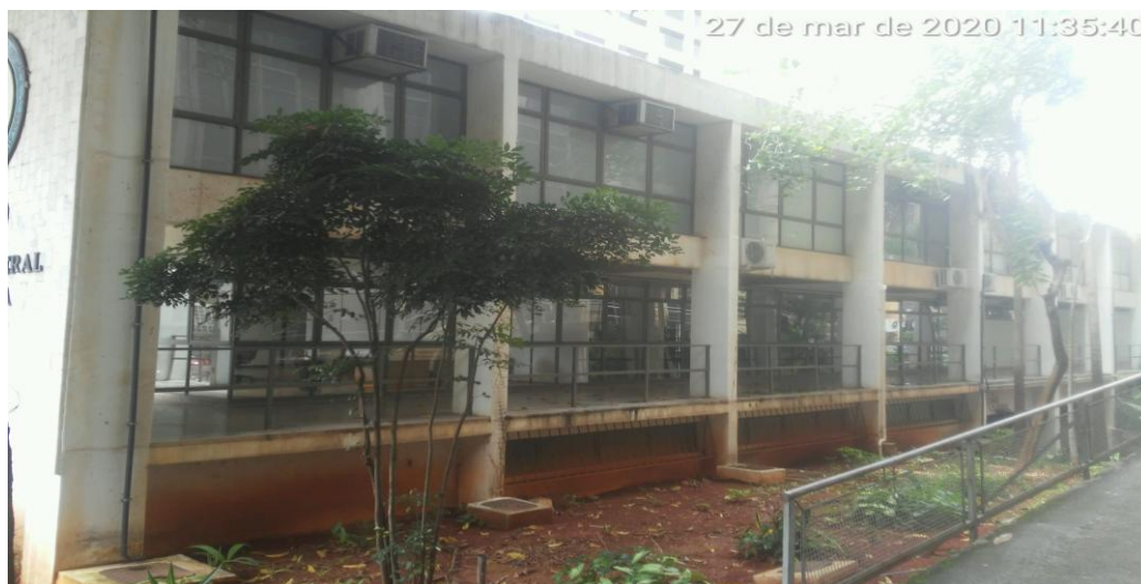
Foto 4 – Fachada lateral direita da Edificação
