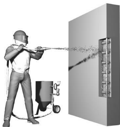
Figura 5 - Remoção da corrosão com jateamento abrasivo
