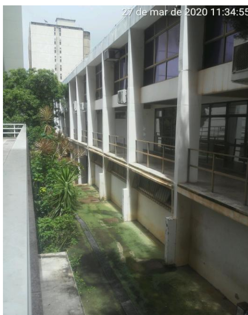
Foto 5 – Fachada lateral esquerda da Edificação
