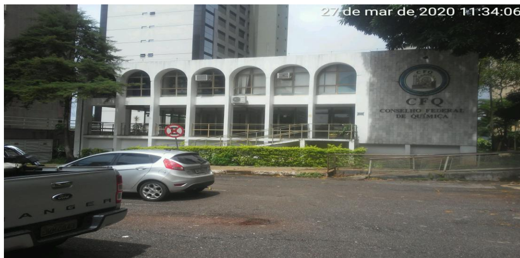
Foto 2 – Fachada principal da Edificação
