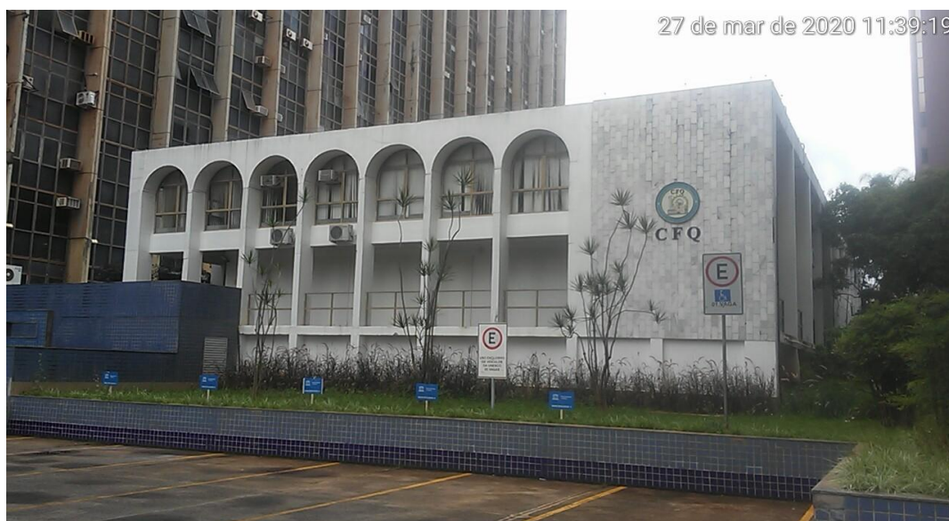
Foto 3 – Fachada posterior da Edificação
